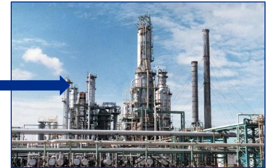
Biorrefinería a escala industrial
